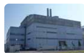
熱供給プラント
