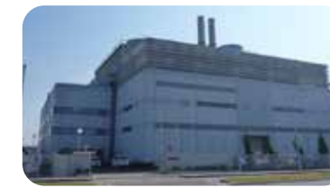
KHC熱供給プラント
