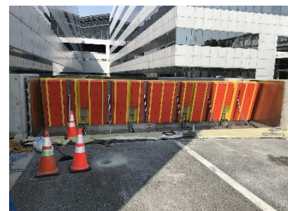
大型止水版の設置
