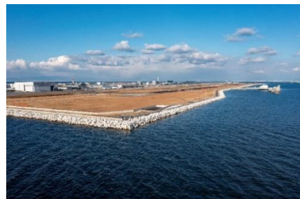
消波ブロック設置
