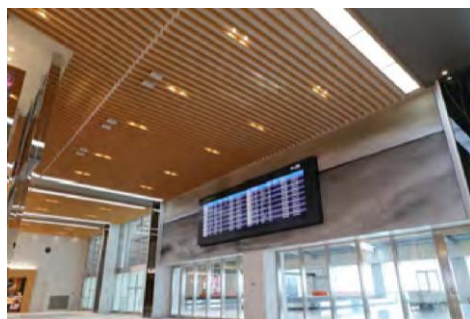
ターミナルビルへのLED導入
