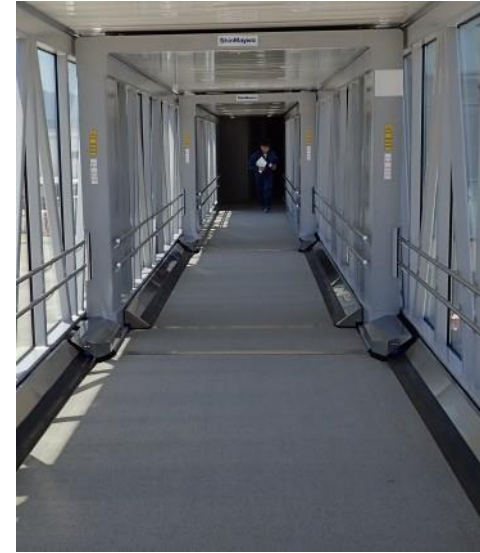
トンネル内（フラットタイプ）
