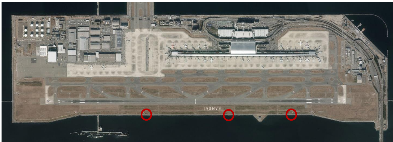
排水ポンプ施設
