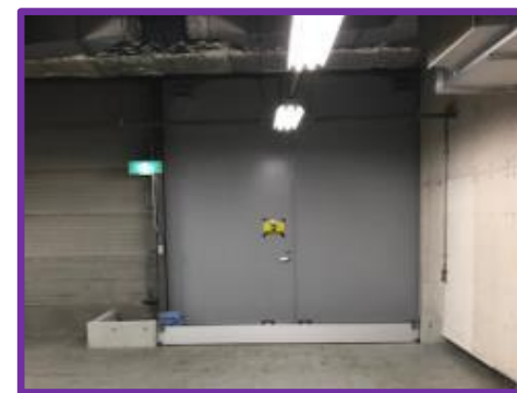
水密扉の設置
