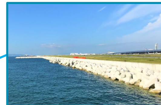
消波ブロック設置
