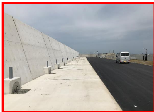
護岸の嵩上げ
