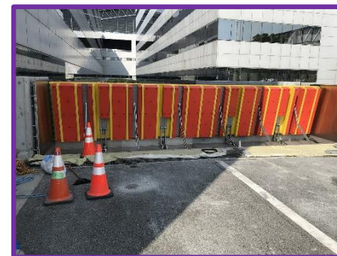
大型止水板の設置
