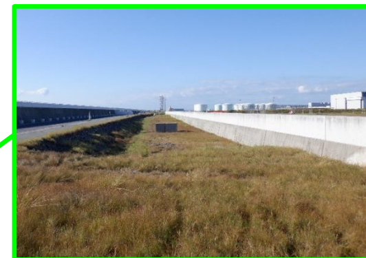
南側防潮壁の嵩上げ
