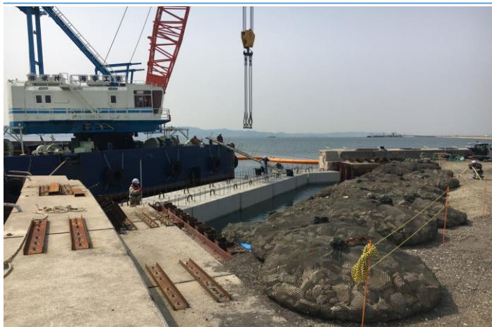
護岸部の補修・嵩上
