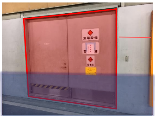
T1地下室以外の重要施設についても順次、水密化を実施
