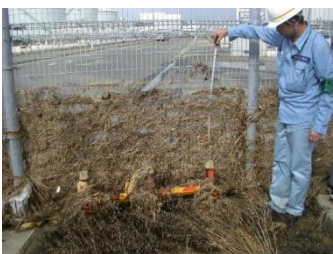
制限フェンス （空港南側・トラック待機場付近）
