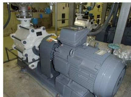
衛生ポンプの電動機高効率化
