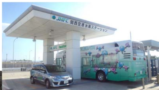
水素ステーション
