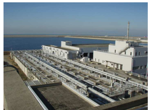
浄化センター
