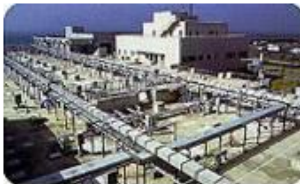
浄化センター
