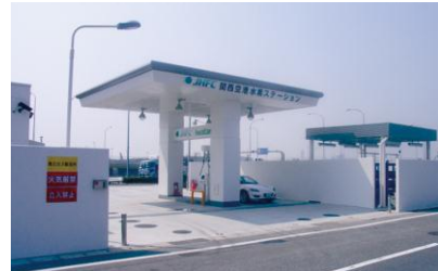
水素ステーション
