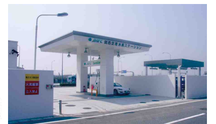
水素ステーション
