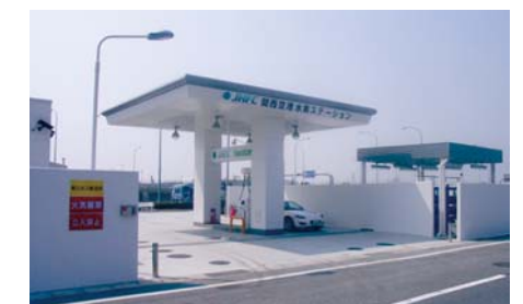
水素ステーション
