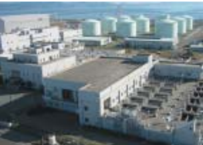
浄化センター
