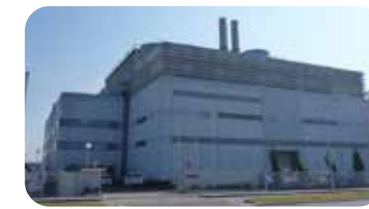
KHC熱供給プラント
