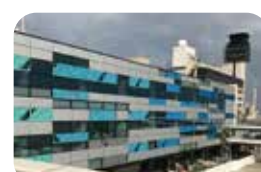
ターミナルビル外壁の遮光パネル
