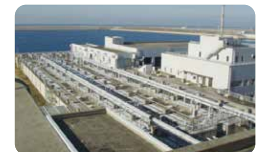
浄化センター
