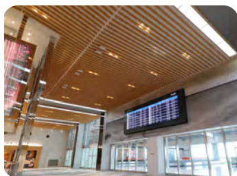
ターミナルビルLED照明(ITAMI)
