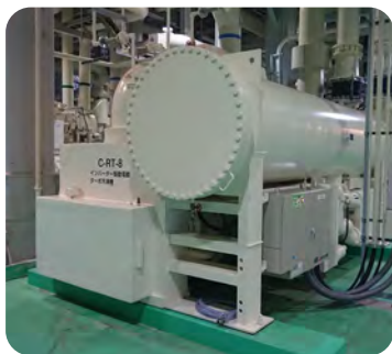
熱供給インバーターボ冷凍機
