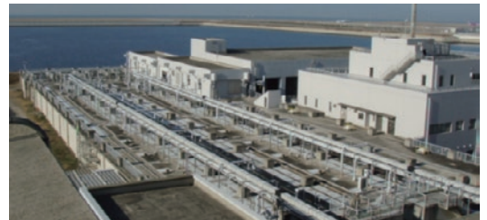
浄化センター
