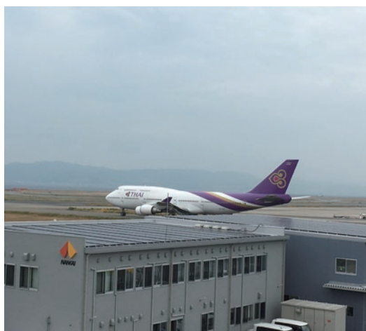
南海バス上屋屋根の太陽光発電
