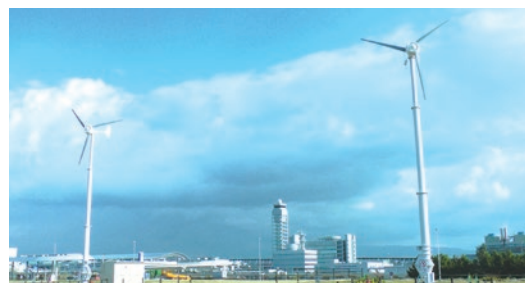
小形風力発電機
