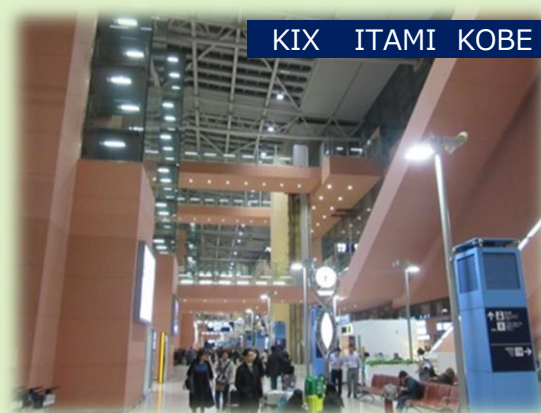
ターミナルビル等へのLED導入
