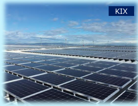
ターミナルビル屋上への ソーラーパネルの設置
