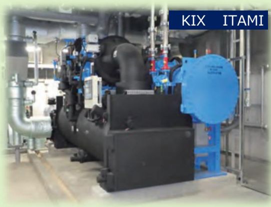
空調機器の高効率化
