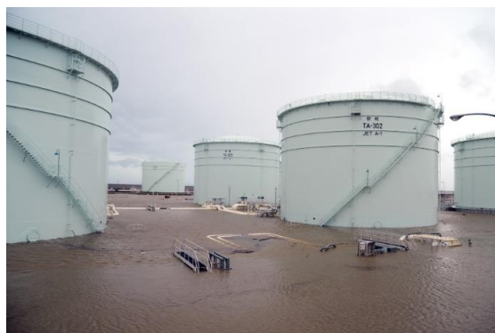
給油地区浸水
