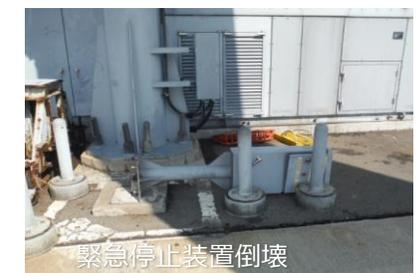
緊急停止装置倒壊
