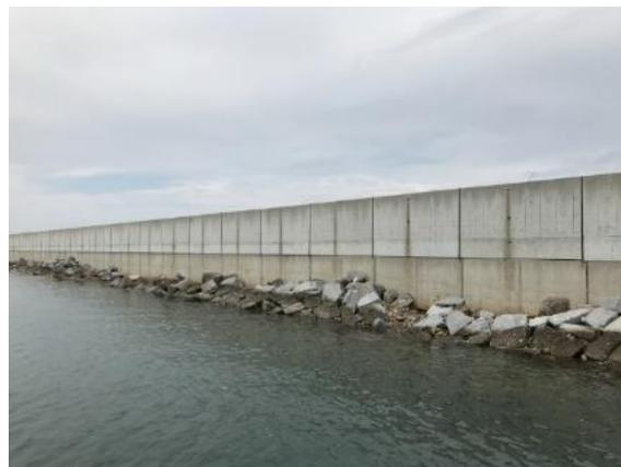
護岸被覆工の破損
