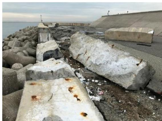
護岸上部工の破損
